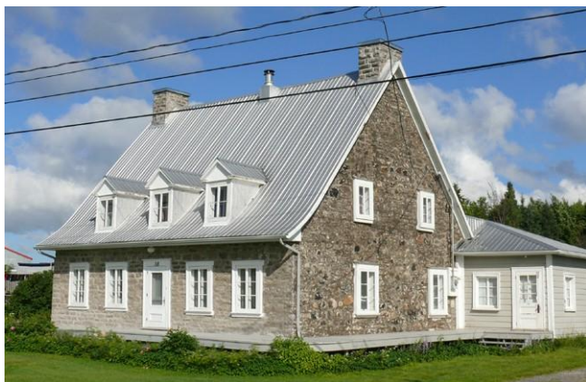
Figure 1 Maison à toit à forte pente et à larmier court avec toiture très pentue à l'avant-toit légèrement recourbé et ouvertures disposées symétriquement en façade.
