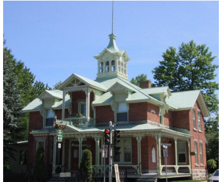
Figure 13 Maison Josaphat-Gareau MRC de Montcalm, Photo : Jean-François Rodrigue 2006 © MCC
