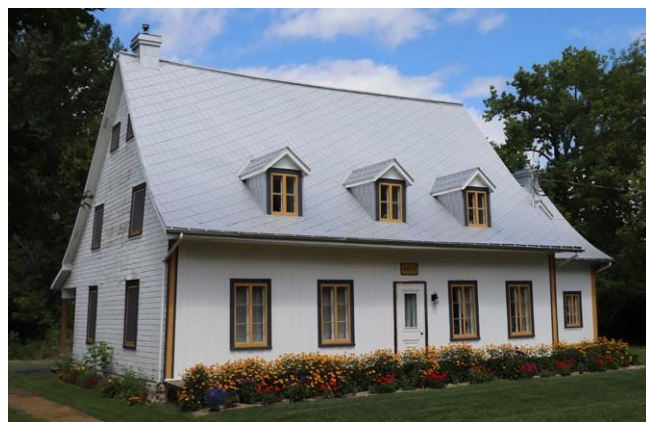
Figure 2 Maison à toit à forte pente et à larmier court en bois au toit très pentu et à la composition presque symétrique des ouvertures en façade.
